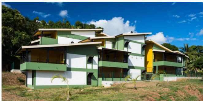
Logements Société immobilière de Mayotte _ Dominique Tessier, Architecte
