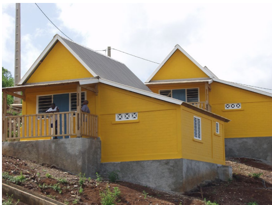
Logement en accession sociale Société immobilière de Mayotte et Vincent Liétar architecte
